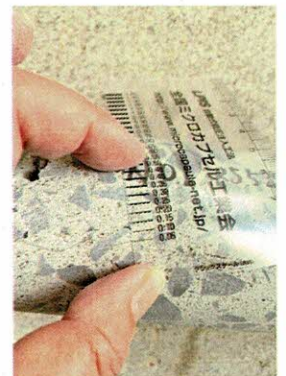
注入後のコア
