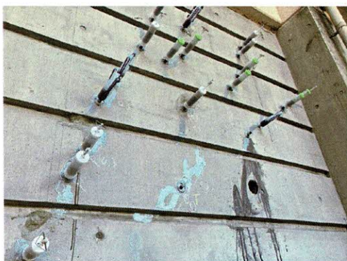
ジオポリマー注入状況
