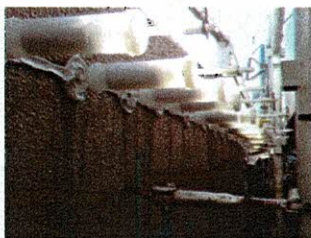
ジオポリマー注入状況
